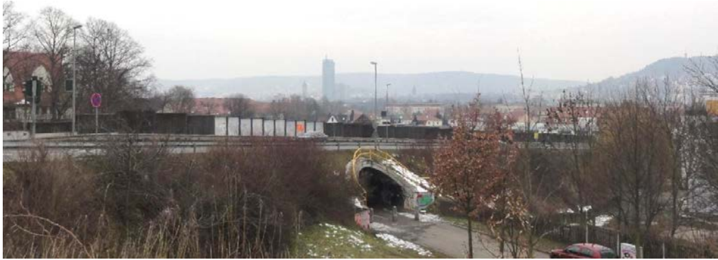
Foto: Lärmschutzwände entlang des Jenzigweges
