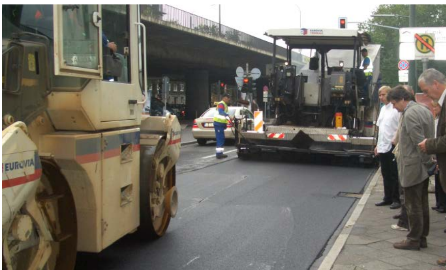
Foto: Einbau eines lärmoptimierten Asphaltbelages in Düsseldorf
