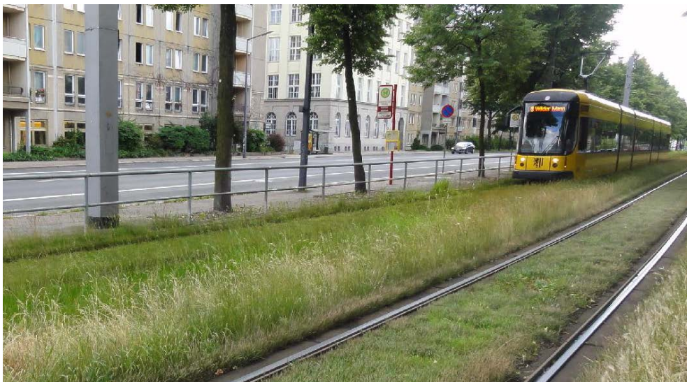
Foto: Beispiel für hoch liegendes Rasengleis (Dresden, Albertstraße)
