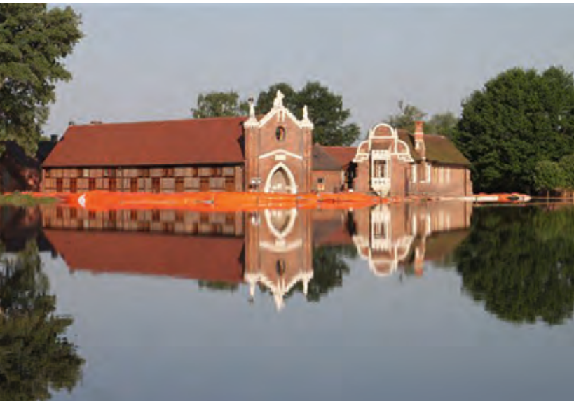
Hochwasserschutz mit mobilem wassergefülltem Schlauchsystem
