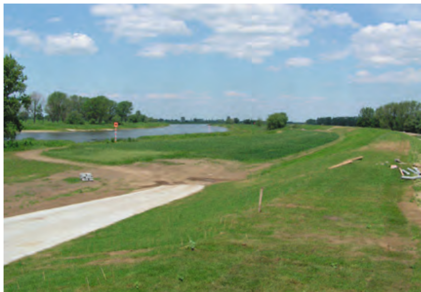
Hochwasserschutzdeich an der Elbe
