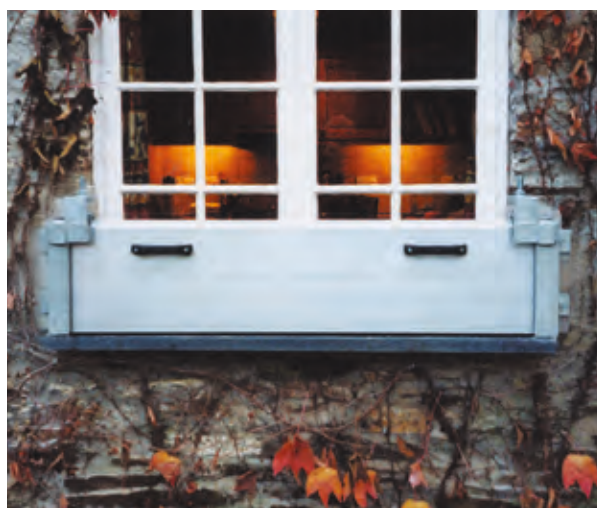
Hochwasserschutz an Fensteröffnungen
