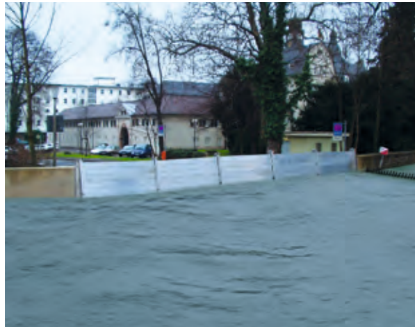
Mobiler Hochwasserschutz mit Dammbalken
