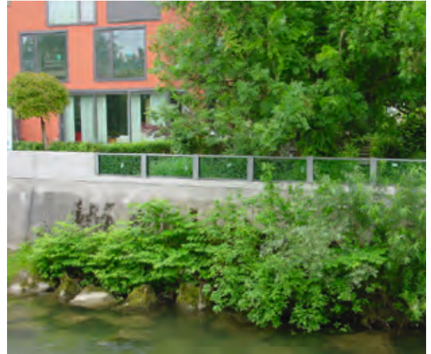
Hochwasserschutzwand mit Sicherheitsglas
