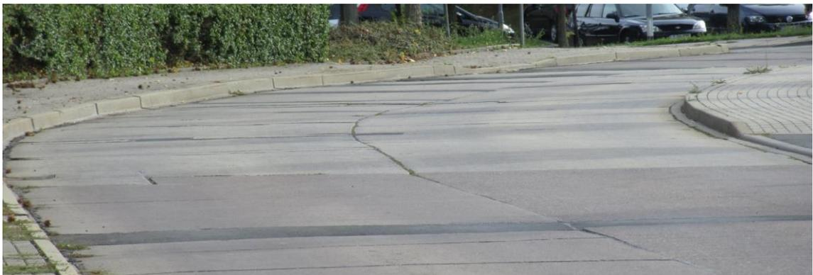
Foto: Betonplatten-Fahrbahn mit regelmäßigen Längs- und Querfugen sowie zusätzlichen Ausbesserungen in Asphaltbauweise (Schrödingerstraße)
